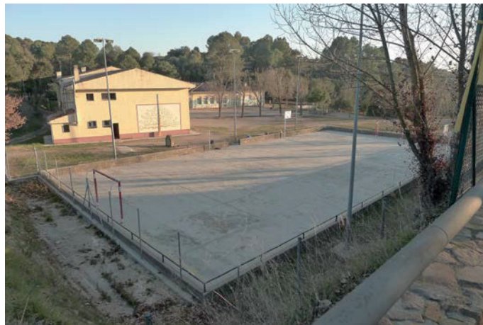
Imatge de la cantonada nord-oest del pati, on s'ha instal·lat la tanca recentment. Font: Voltes.coop. 13/02/2019.
